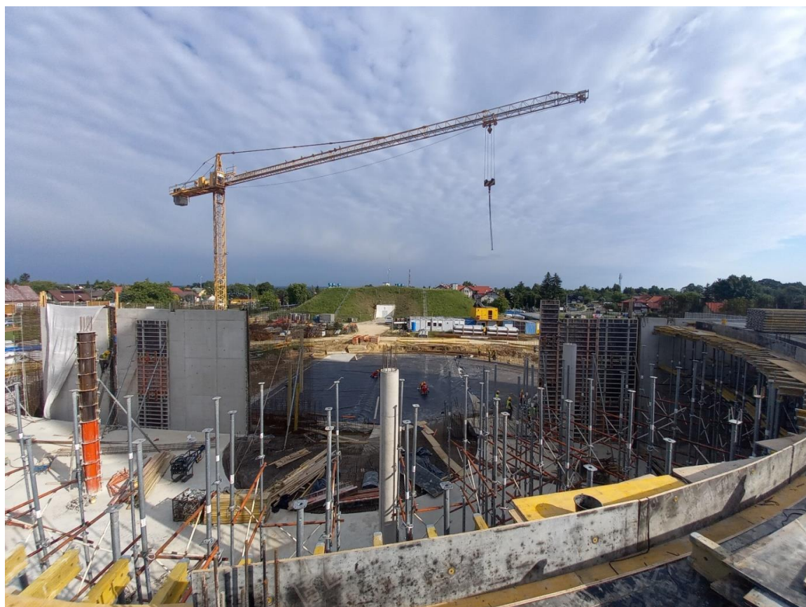
Rozbudowa zbiorników wody pitnej na os. Pobitno w Rzeszowie
